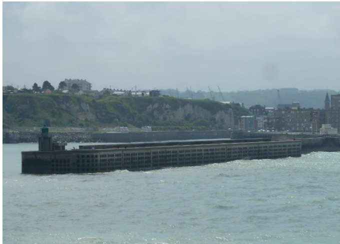
Digue en caisse Jarlan de Dieppe
